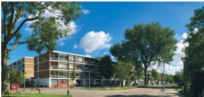
overgang naorlogs deel Boerhaavelaan gemarkeerd door monumentale boom
